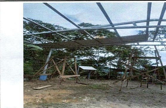
Foto 5: COLOCACIÓN DE LÁMINAS TROQUELADAS DE 23 PIES Y 18 PIES CALIBRE 26
