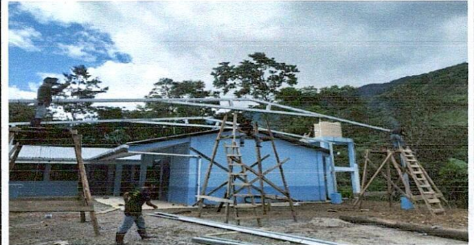
Foto 2: COLOCACIÓN DETIJERA DE ESTRUCTURA METALICA PARA ENTECHADO GALVANIZADA 4X4 CHAPA 16
